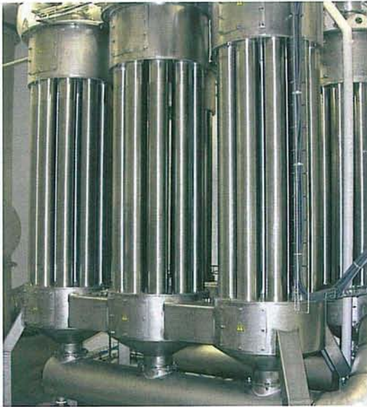
Abb. 2: Elektrofilter entfernen feste Rauchteilchen, Teer, Wassertröpfchen und Nebel aus der Abluft.
