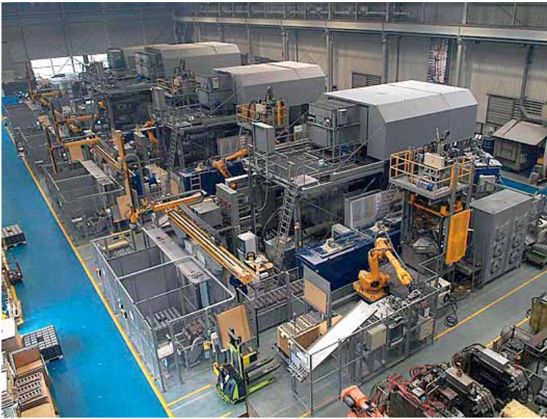
5 x ULTRAVENT® UV-II 15002/EE-EW15 Dezentrale Filteranlagen für 5 Bühler Druckgießmaschinen 2200t Absaugung von Trennmittel-Rauch am Sprühroboter
