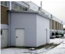
Mit einem frostfesten Gehäuse ist die energieeffiziente KMA AAIRMAXX® auch für die Außenaufstellung geeignet.
