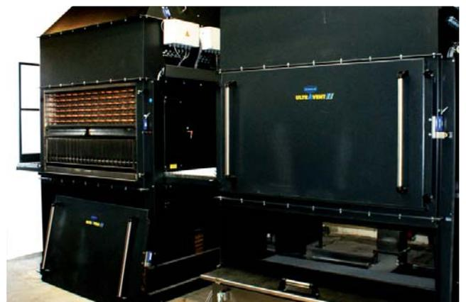
Abb.: ULTRAVENT® Anlage mit Demister, Elektrofilter und Abluftwärmetauscher (von unten nach oben). Zwischen Elektrofilter und Wärmetauscher befindet sich die automatische Filterwaschanlage.
