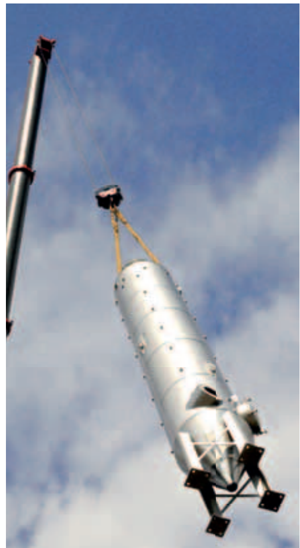
Einbringung einer Filterröhre in ein Fabrikgebäude
