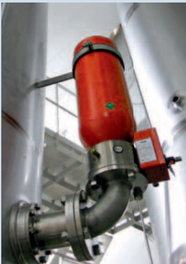
Zusätzliche Sicherheit durch ein Explosionsunterdrückungssystem für explosive Stäube
