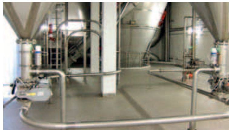
AAIRMAXX® ESP Filter mit Austrittsluftscheunen und Röhren für den Transport des anfallenden Staubes
