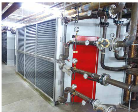
Bild 2: KMA-Ultravent-System, Detailaufnahme Filtereingang.
