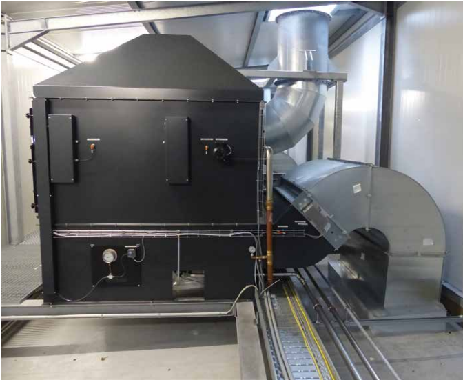
Bild 2: KMA-Ultravent-System, Detailaufnahme Filtereingang.
