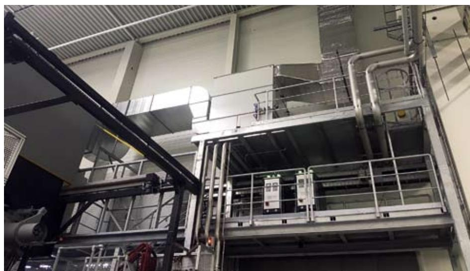
**Der Abluftfilter und die Abluftkanäle können auch wie hier bei der zweiten Gießzelle platzsparend neben der Gießmaschine montiert werden / The exhaust air filter and the exhaust air ducts can also be mounted next to the casting machine to save space**
